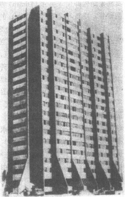
图 1-14 美国 70 年代在匹兹堡建造的一幢配筋高层建筑
