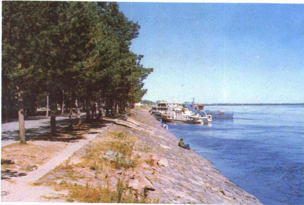
紧临江畔公园的林荫路和护岸工程段
