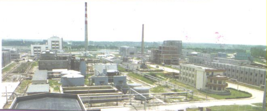
▶ 江汉油田新建的盐化工总厂
