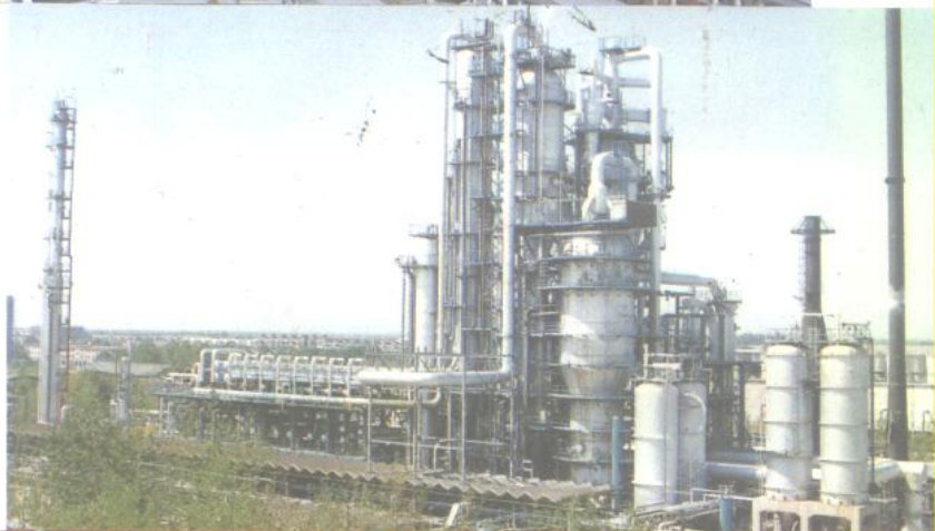
▶ 武汉石油化工厂催化裂化装置
