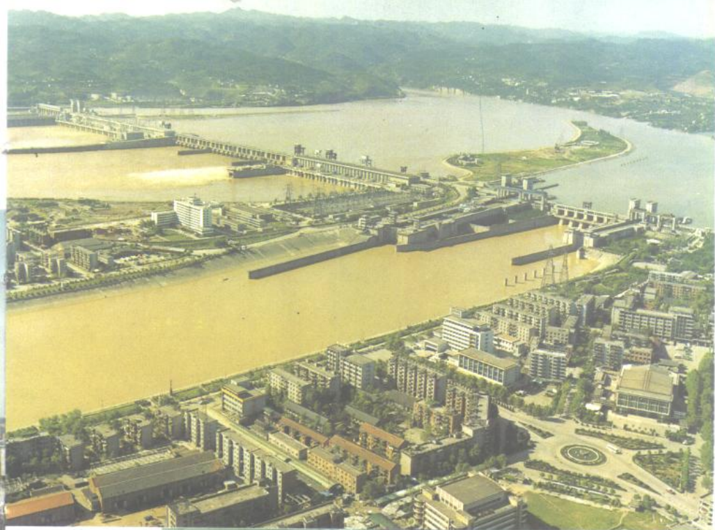
葛洲坝水力发电厂(装机容量271.5万千瓦)
