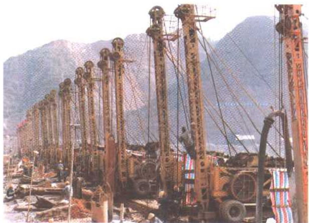
河南黄河小浪底水利枢纽工程 刘凤翔摄
