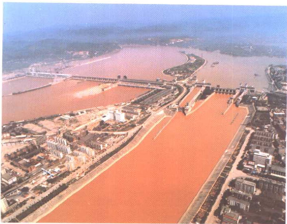
湖北长江葛洲坝水利枢纽工程
