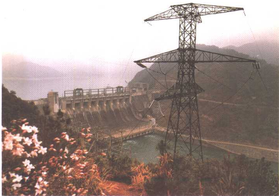
浙江新安江水电站
