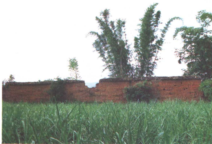
1902 年修筑的耿马土司城墙一角
