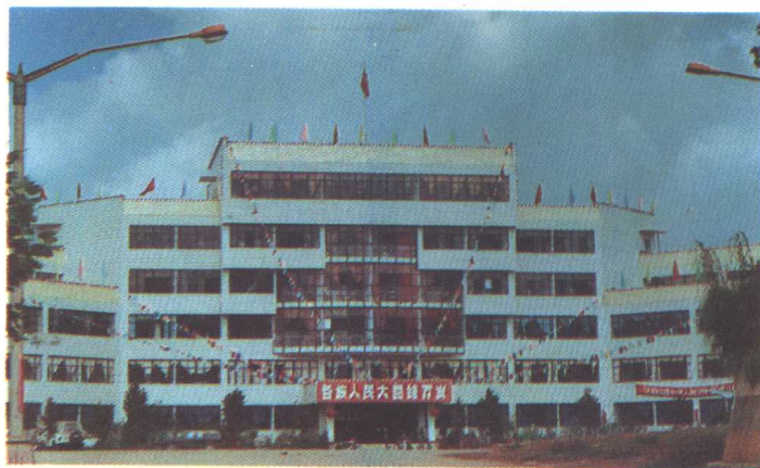
县人大政府政协综合办公楼
