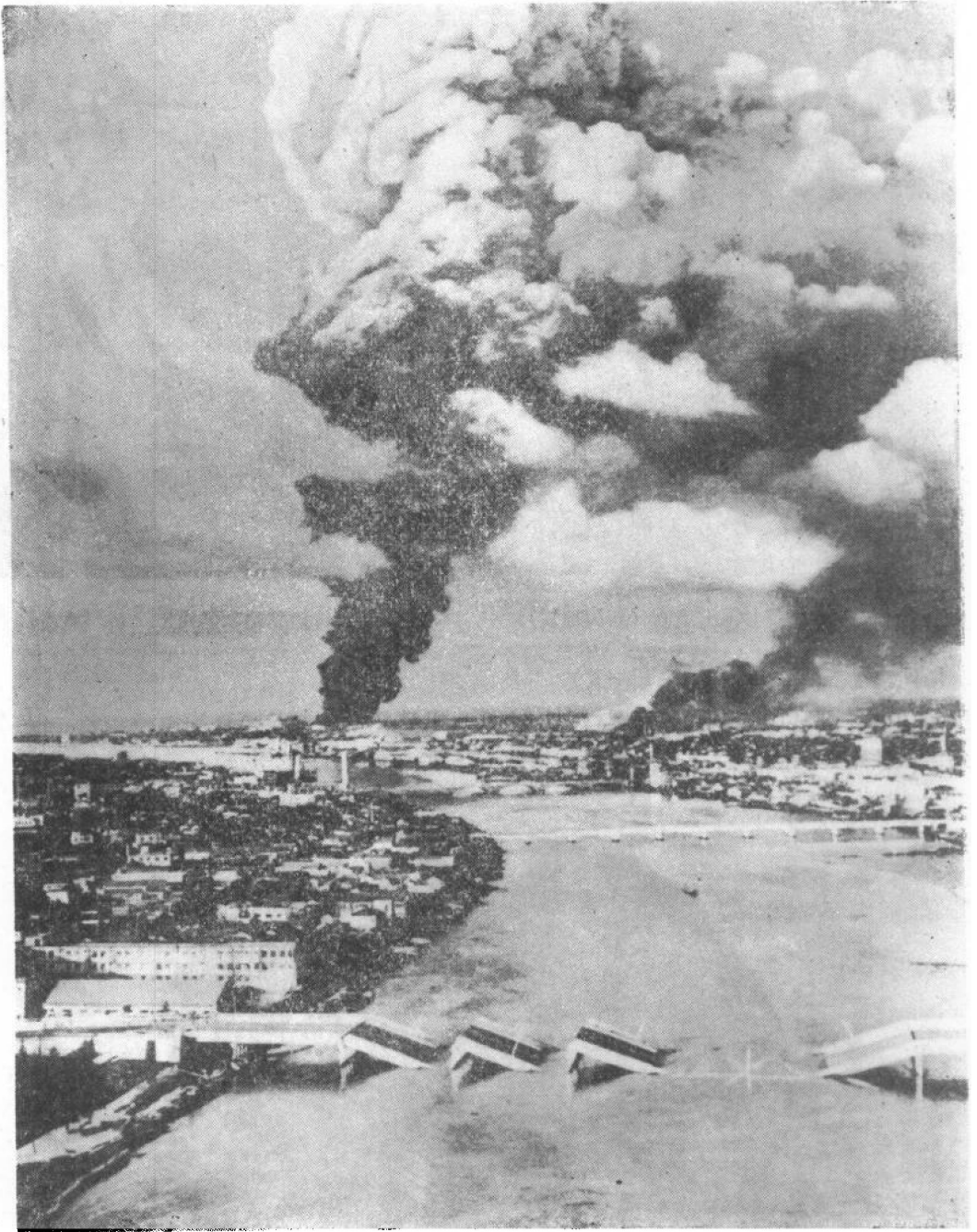
坍毀了的昭和大橋和在它後面冒煙燃燒着的石油貯罐（新瀉日報供稿）
