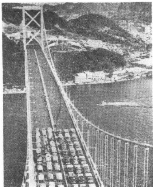
关门桥的静力的载试验
