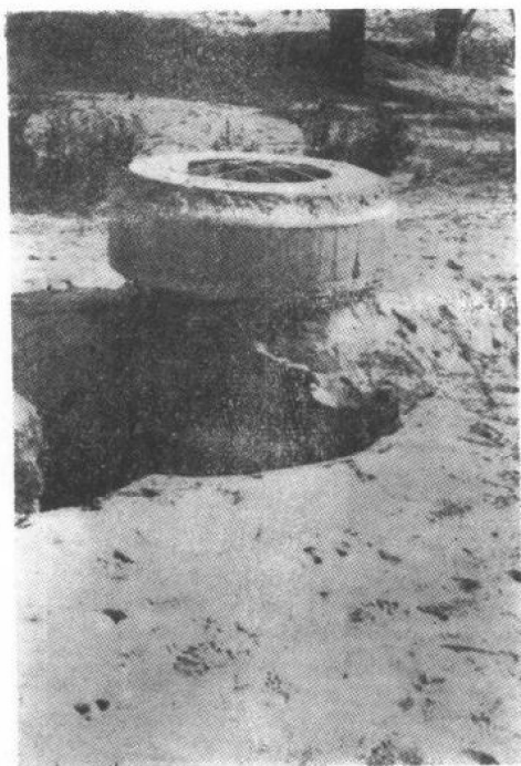
由于液化，一座检查井顶出地面（新泻地震）
