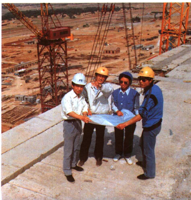
先行——设计人员在施工现场
