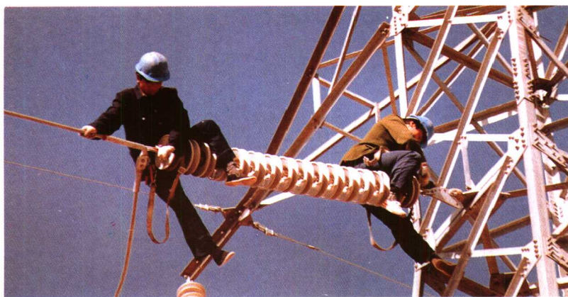
凌空飞燕——架设输电线路
