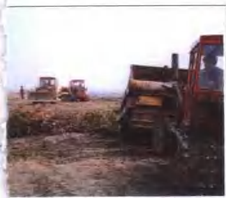
机械化筑堤施工现场
