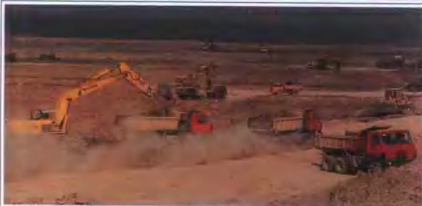
东调南下工程机械化施工现场
