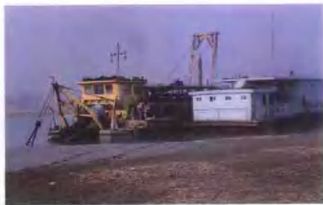
河道疏浚施工现场
