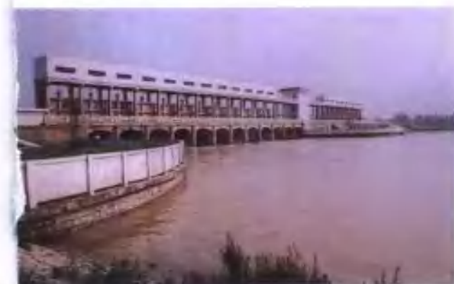
包淦河固镇新老节制闸
