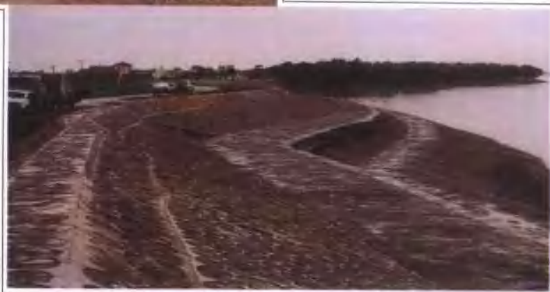
加固后的洪泽湖大堤
