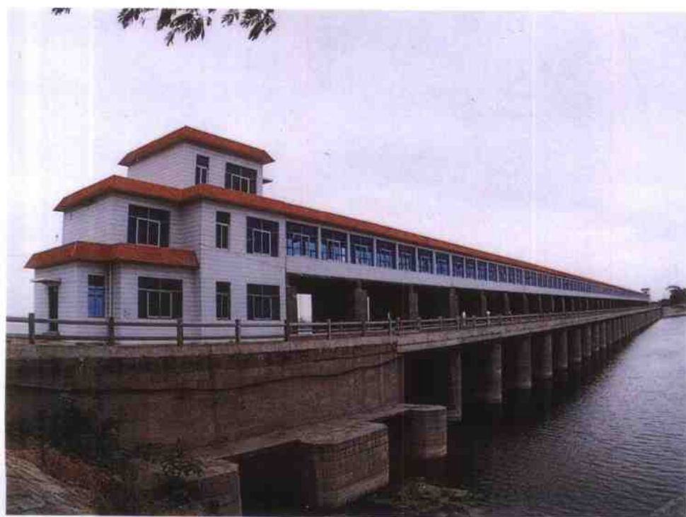
加固一新的南四湖二级坝第一节制闸雄姿
