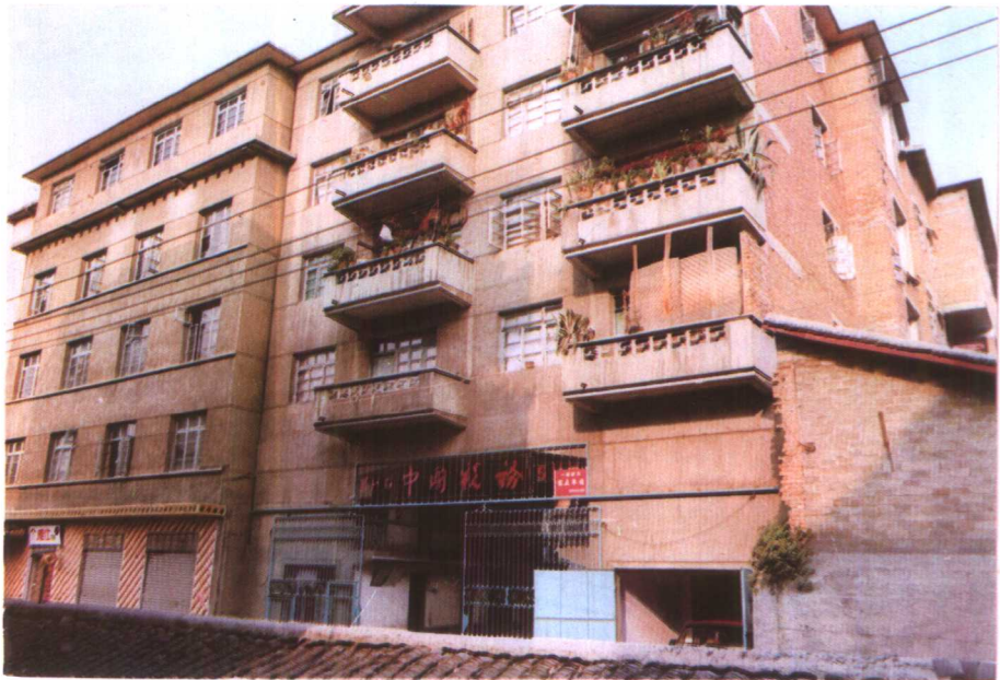
黔东南苗族侗族自治州税务局办公大楼
