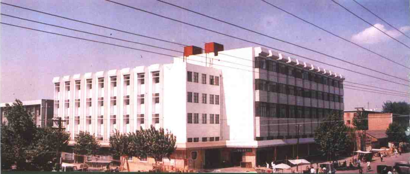
城郊供销社大楼
