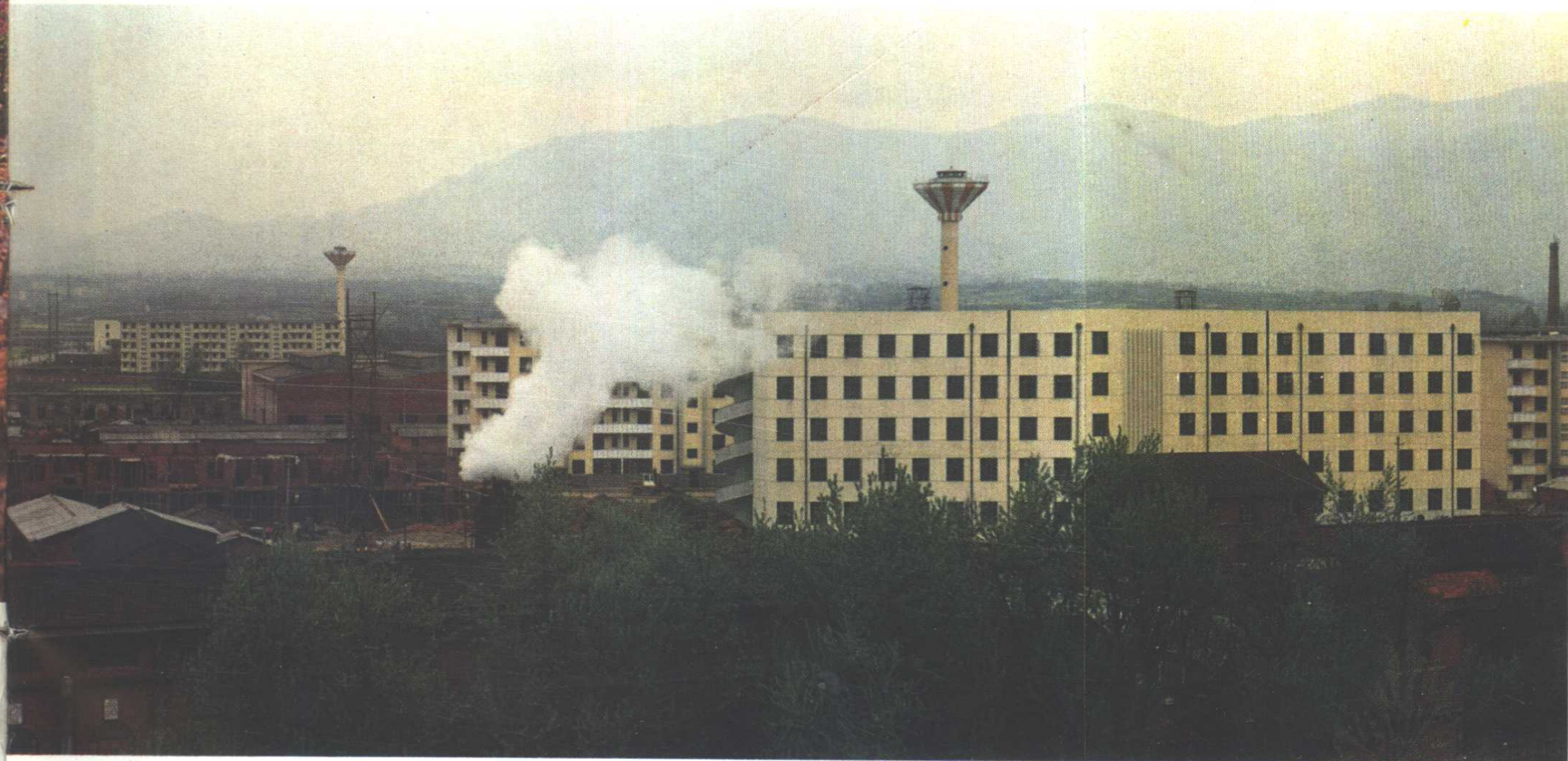
● 建设中的大河坎工业开发区
