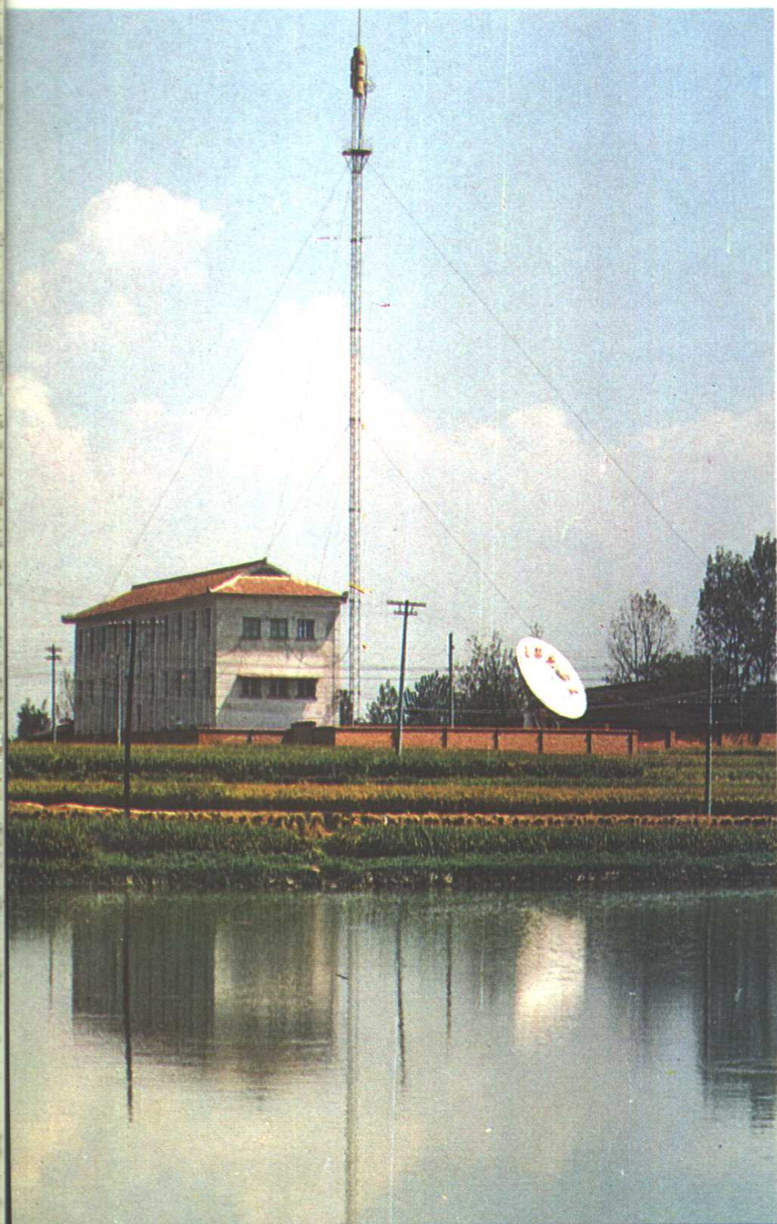
● 县电视发射塔
