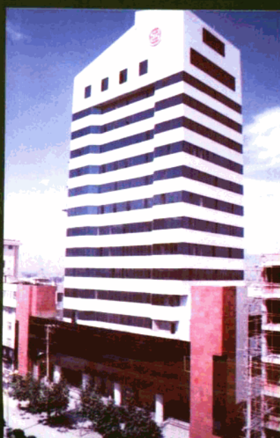
永昌镇第二建筑公司承建的保山地区工行办公大楼
