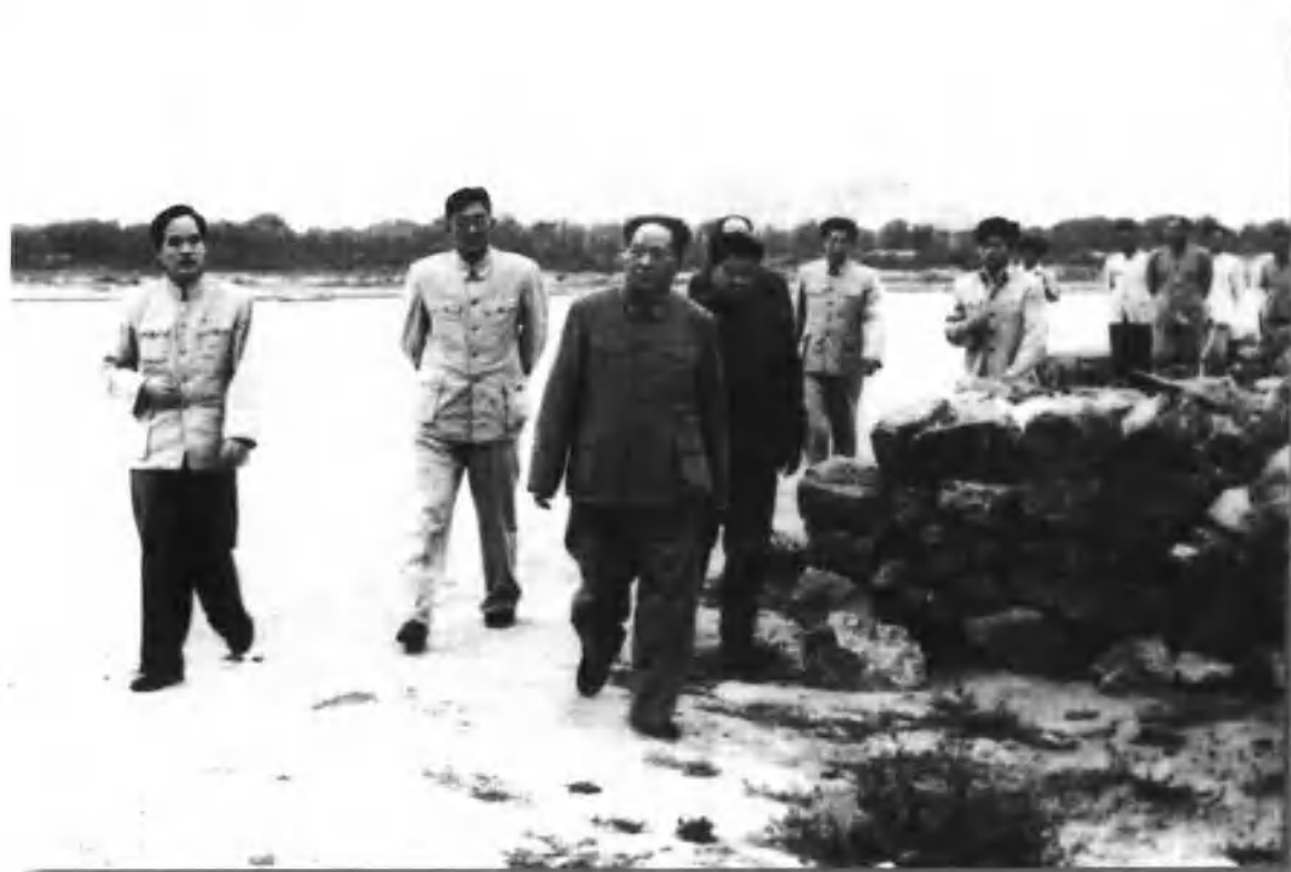
1959年9月20日，毛泽东视察济南泺口黄河大堤
