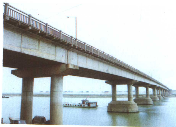
▲ 横跨昌江下游的预应力混凝土T型梁桥——波阳姚公渡大桥
