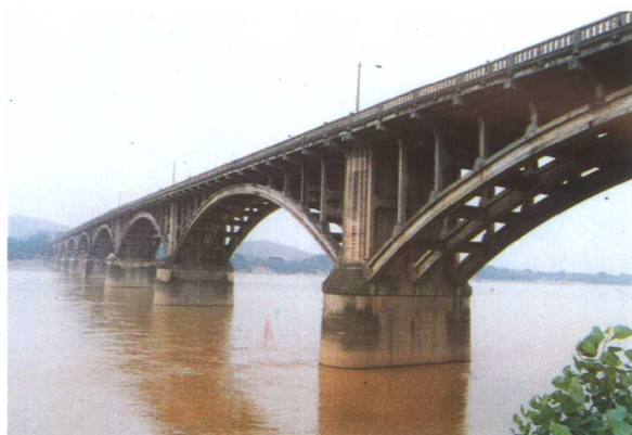
▶ 位于赣州市区东部横跨贡江的大跨径钢筋混凝土肋拱桥——赣州东河大桥
