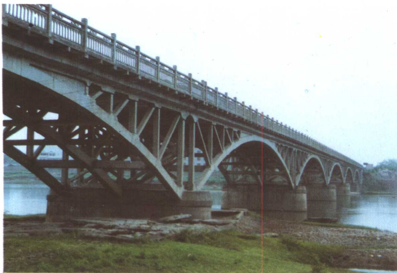
◀ 位处上饶市区的钢筋混凝土桁架拱的前进大桥
