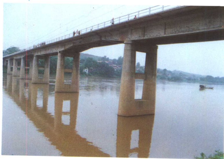
▶ 横跨赣江的钢筋混凝土悬臂梁桥——赣州西河大桥
