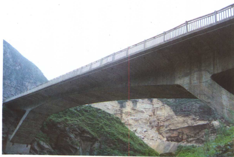
◀ 105国道遂川县境的预应力混凝土斜腿刚构桥——洪门大桥
