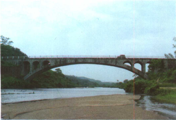
◀ 横跨黄金江的大跨径片石空腹拱桥——峡江新江大桥
