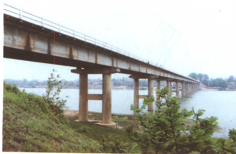
▶ 座落于余干县黄埠镇的黄金埠大桥，上部为钢筋混凝土装配式预应力T梁，下部为薄壁沉井，钢筋混凝土基础
