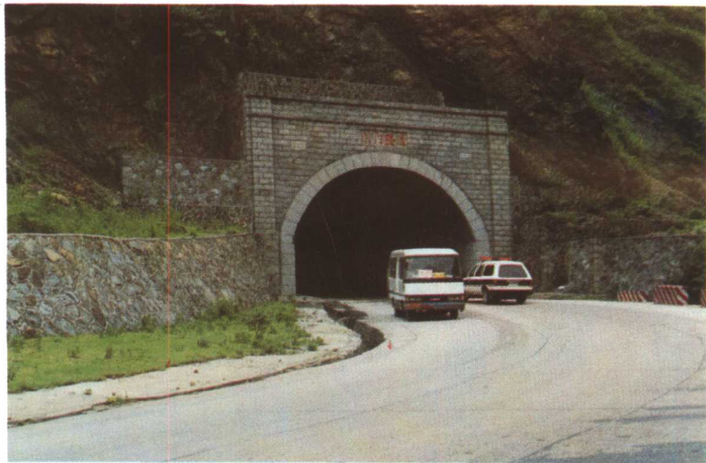
▶ * 105 国道遂川洪门地段的隧道——洪门隧道
