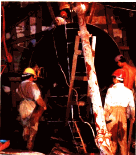
正在施工的三号发电机组机座混凝土浇灌
