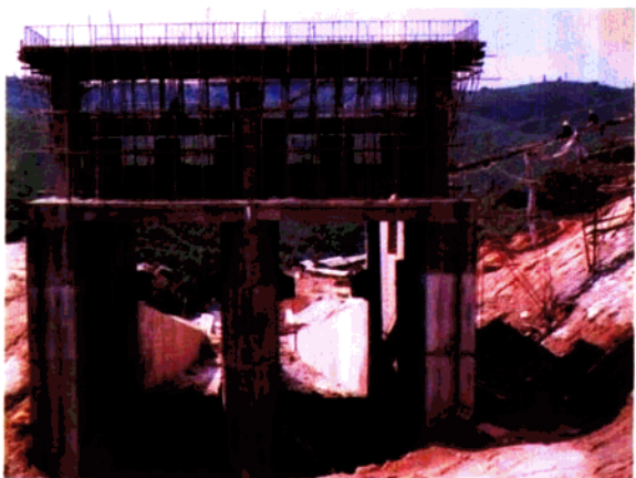
调节水库溢洪道泄水陡槽
