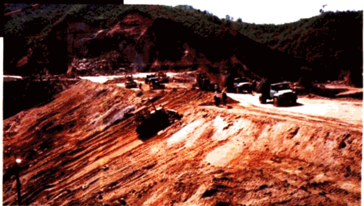
施工期间的水库大坝
