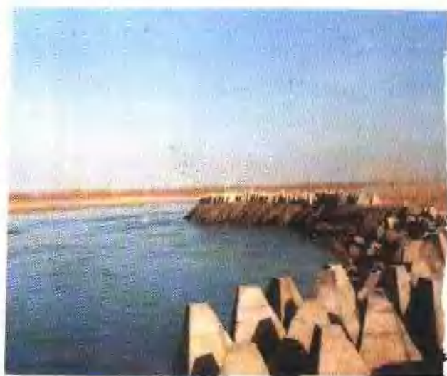
宁夏吴忠市河段秦渠关护岸工程
