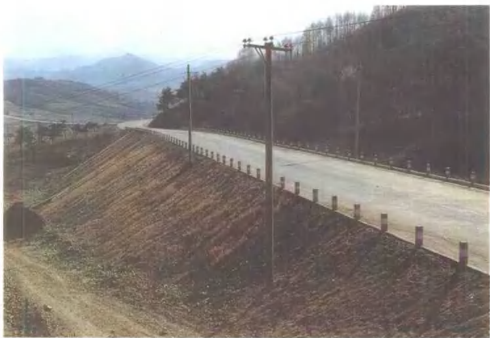
△ 国家二级公路——施南线
