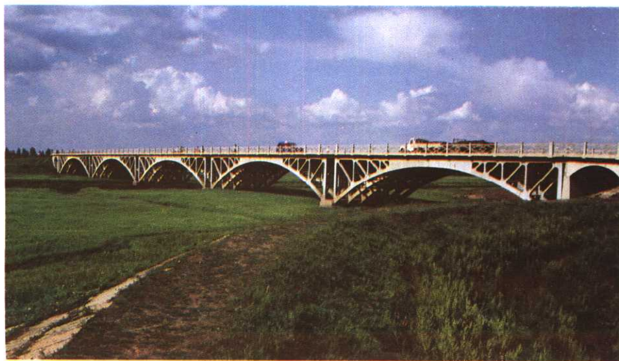
伊通河桁架拱桥
