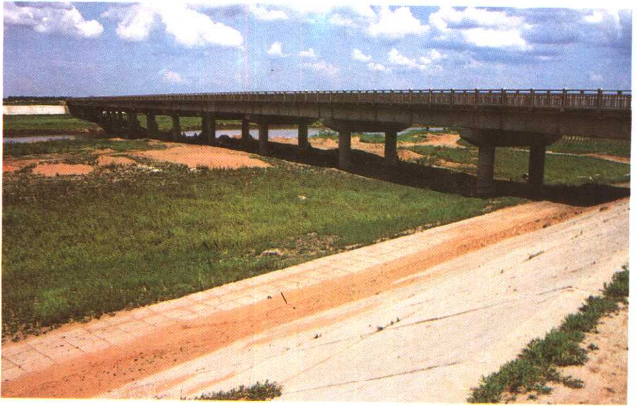
饮马河梁式大桥
