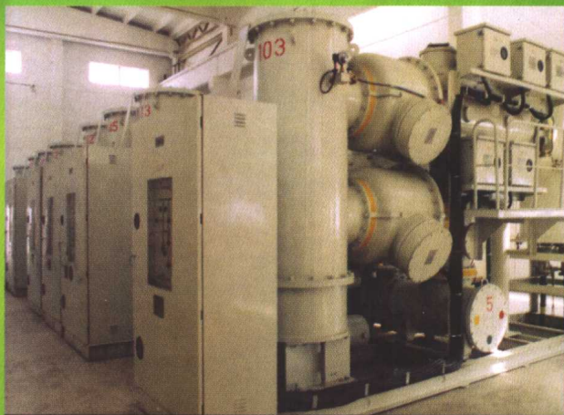
● ZF6-110 型六氟化硫封闭式组合电器
