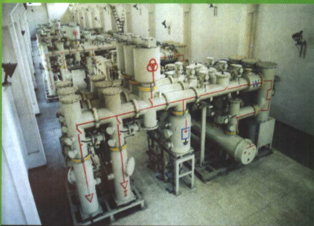
● ZF6-220 型六氟化硫封闭式组合电器
