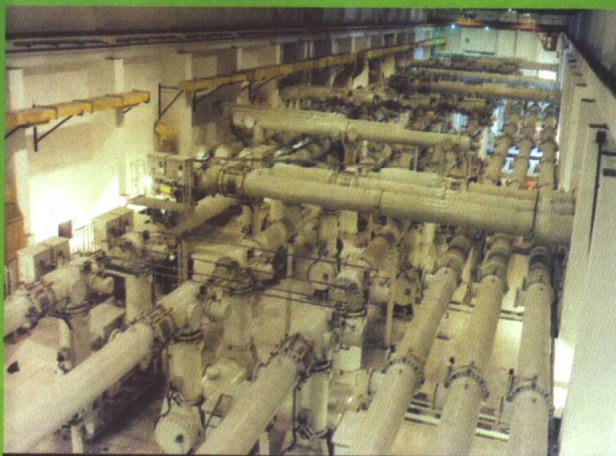
● ZF6-500 型六氟化硫封闭式组合电器
