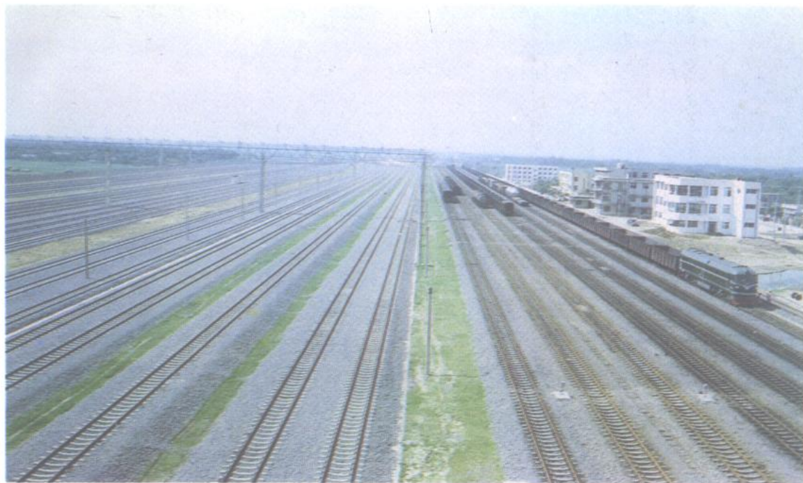
京九铁路阜阳编组站
