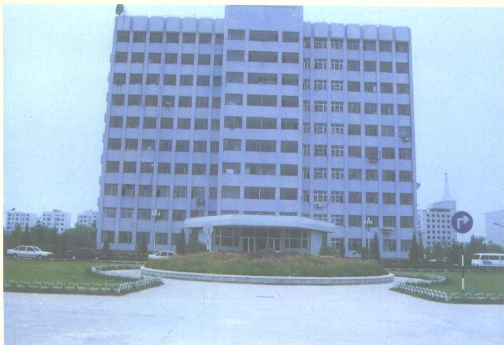
中共阜阳市委办公大楼
