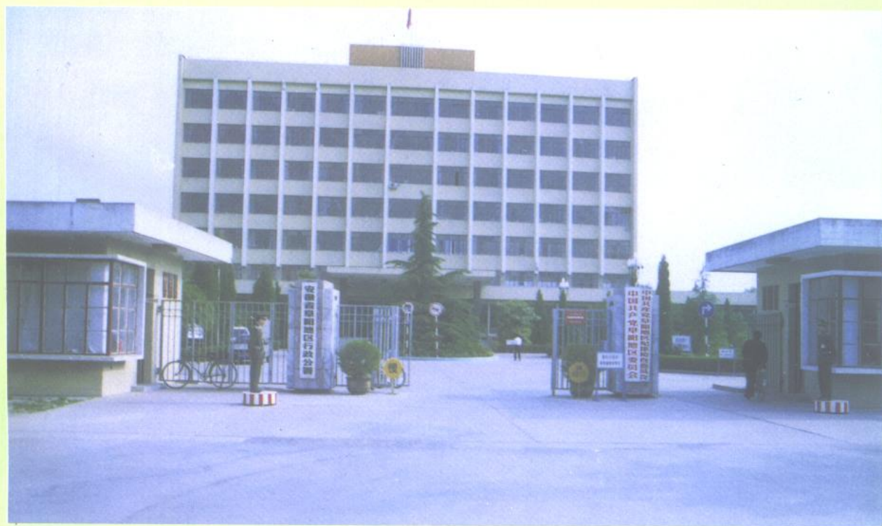
阜阳市人民政府办公大楼
