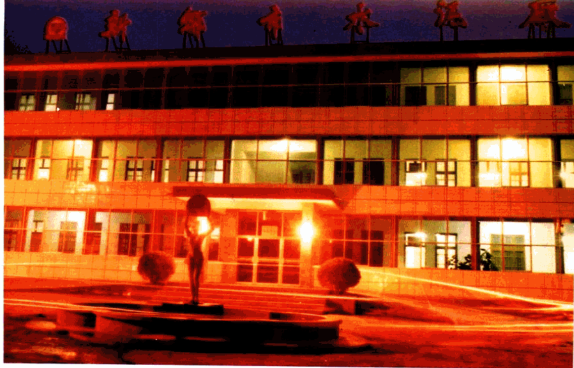
市水泥厂办公楼
