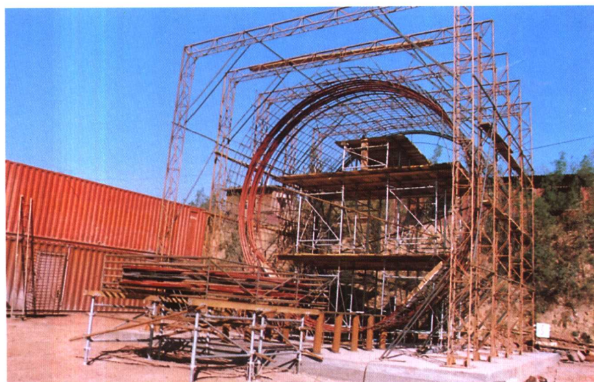
排沙洞预应力衬砌 钢绞线安装工艺试验
