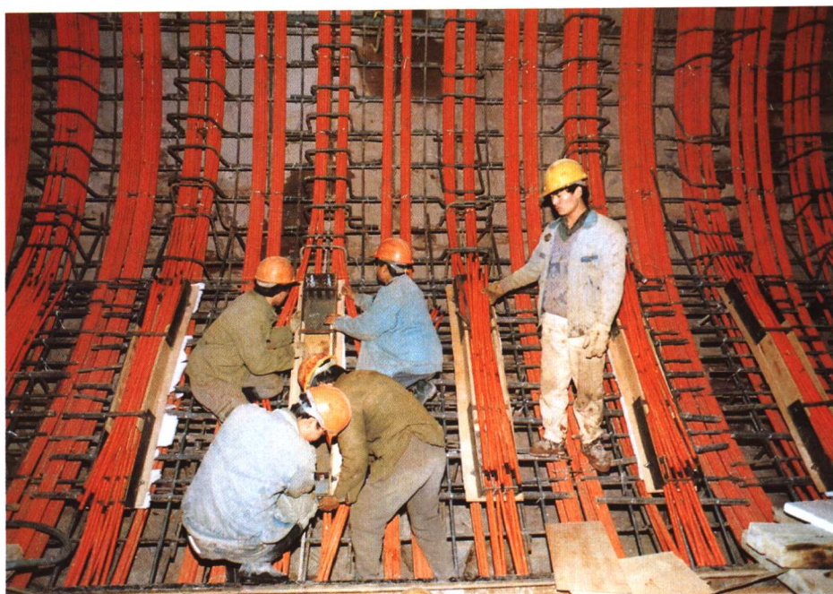
排沙洞预应力衬砌 锚具槽的固定
