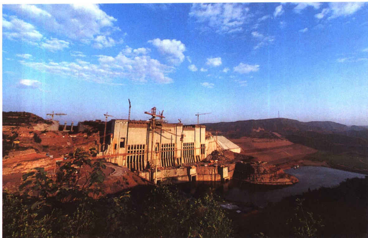
小浪底水利枢纽进水塔远景
