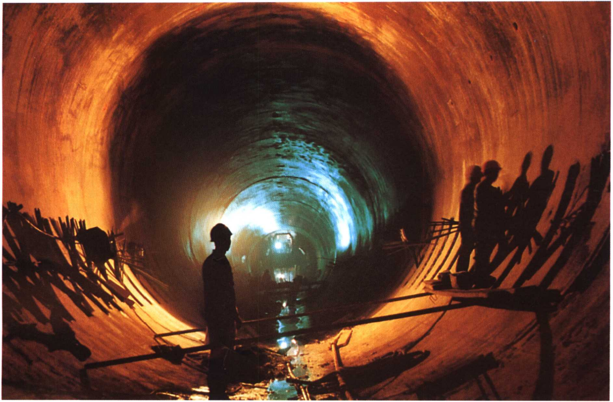
混凝土衬砌浇筑完成后锚索张拉前锚具槽的准备
