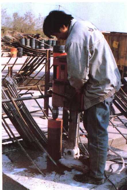
锚具槽附近钢绞线最密集区混凝土钻孔取样
