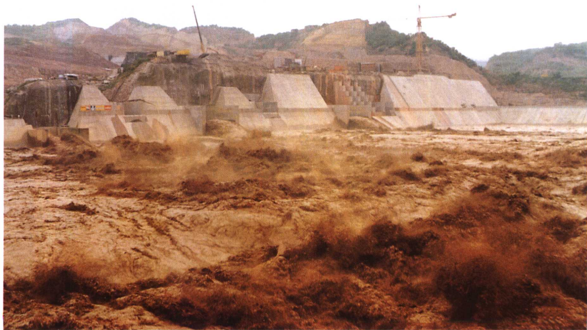
小浪底水利枢纽泄水建筑物出口（在建）
