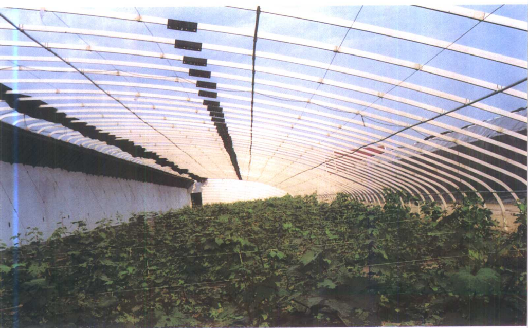
圆拱式钢塑复合材料组合式无立柱日光温室（杜永胜提供）
