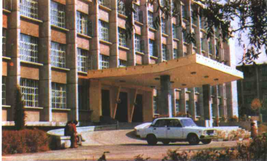
通化钢铁公司办公楼
