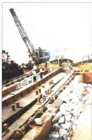
“底开式”抛石船在下游钱堤截流段进行“龙口护底”作业
