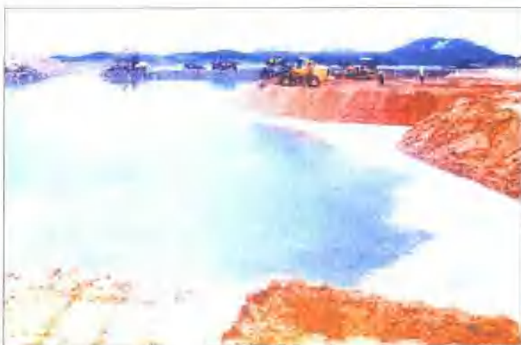
钱堤、石碴堤之间填沙振冲
