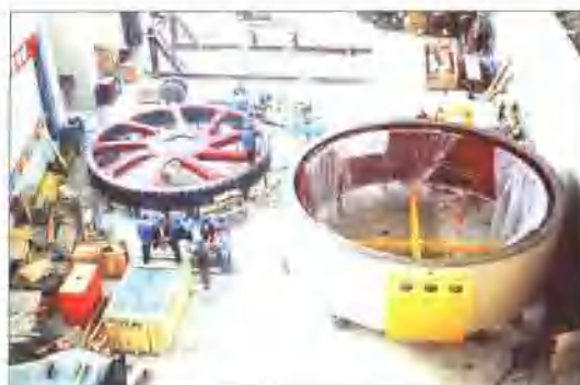
发电机组设备组装
