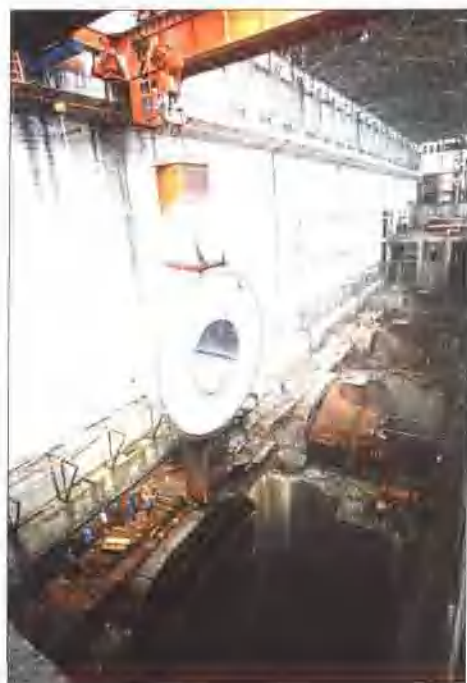
机组管形座吊装
