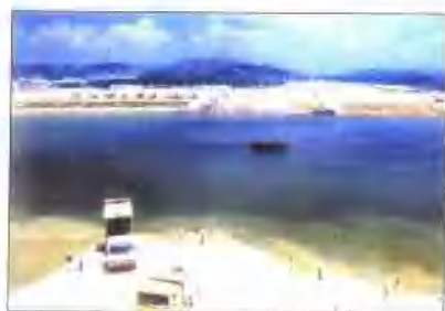
截流施工中的120m龙口
