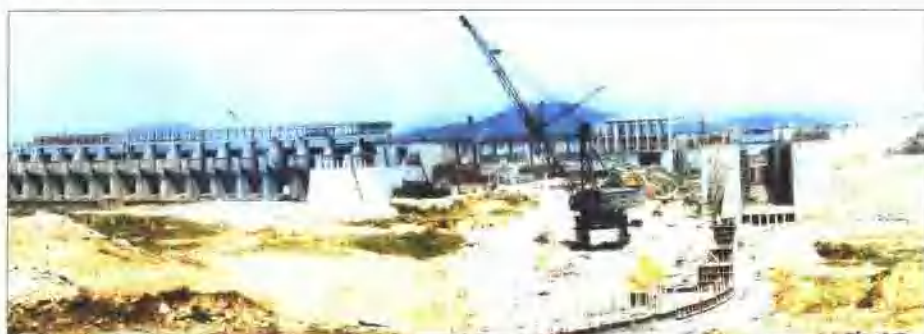
施工中的船闸、电站、溢流坝下游面
