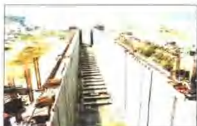
施工中的船闸闸室
