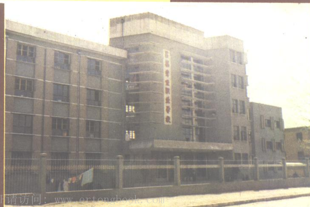
吕梁地区聋哑职业学校 ▶
