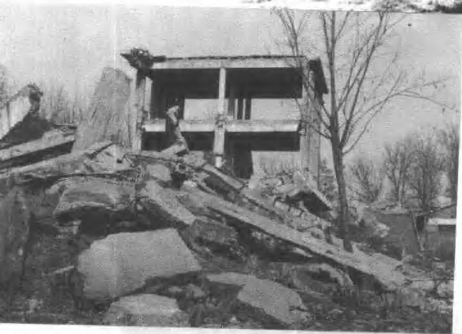
3. 河北工程技术学院图书馆主楼震后形成的瓦砾堆。
