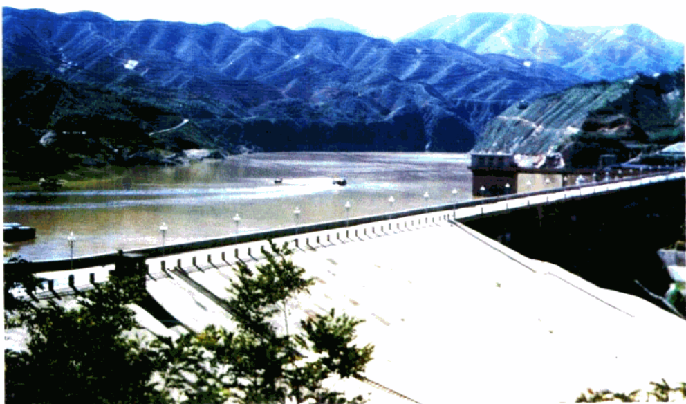
黄河明珠刘家峡水库大坝
