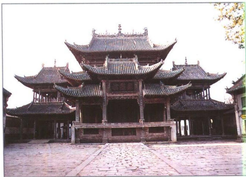
9. 社旗县山陕会馆古戏楼
