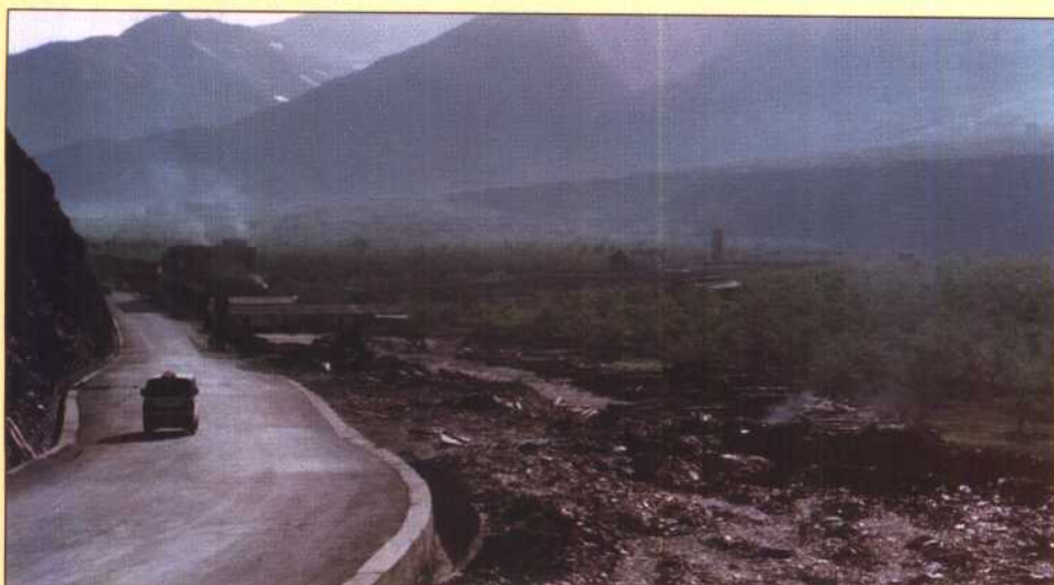
新建威凤路改扩建工程竣工通车
