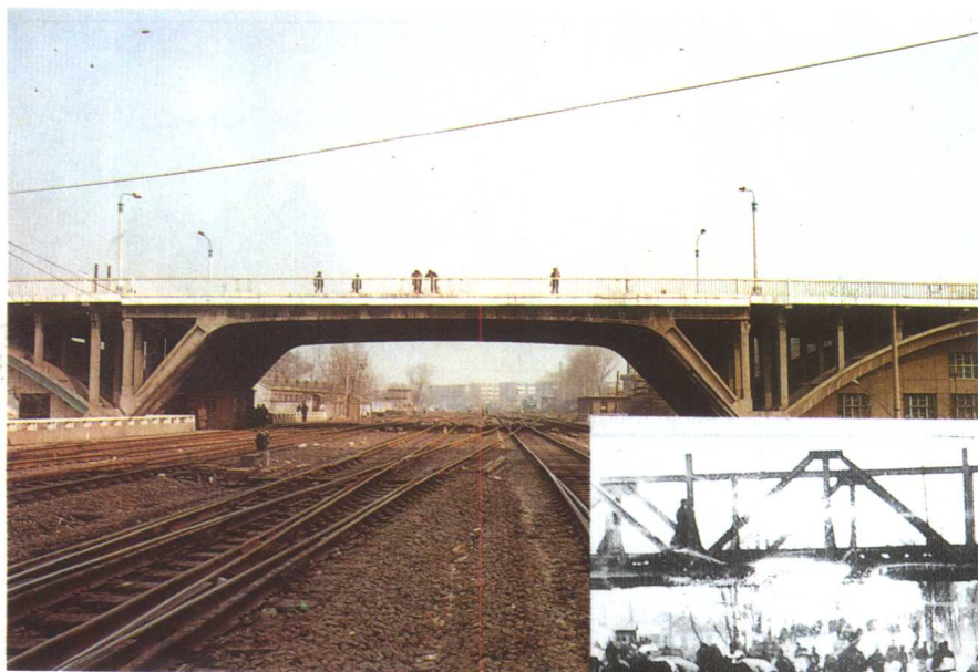
改建后的济南车站东天桥
