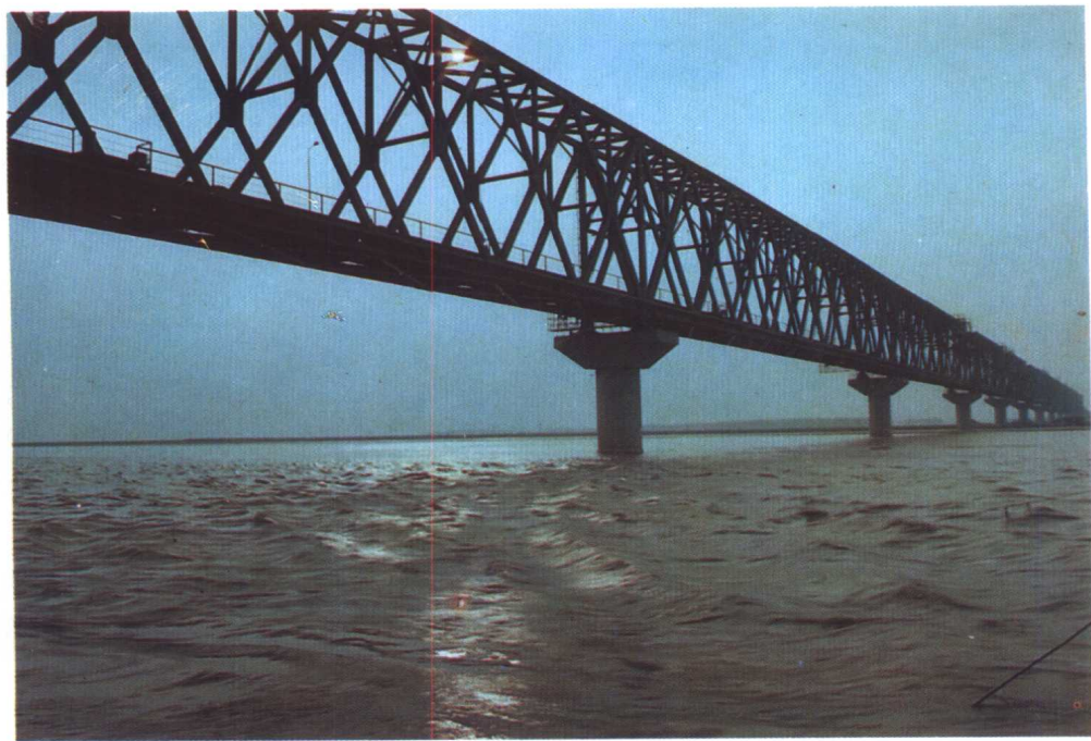
新建的新兖铁路长东黄河铁路特大桥
