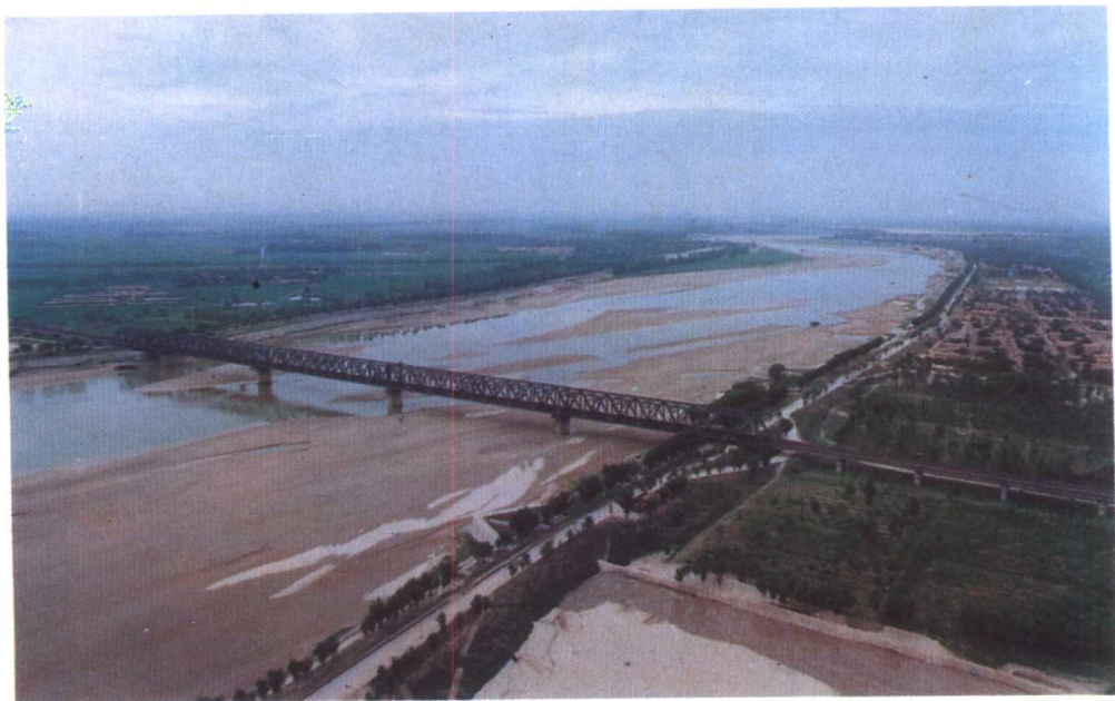
新建的津浦铁路曹家圈黄河铁路特大桥
