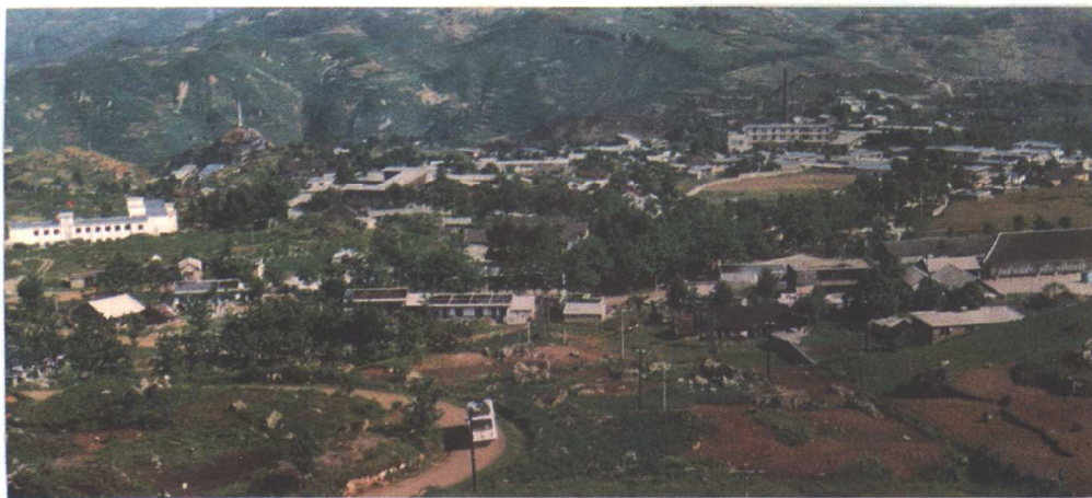
大厂镇及晴隆锑矿厂全景
