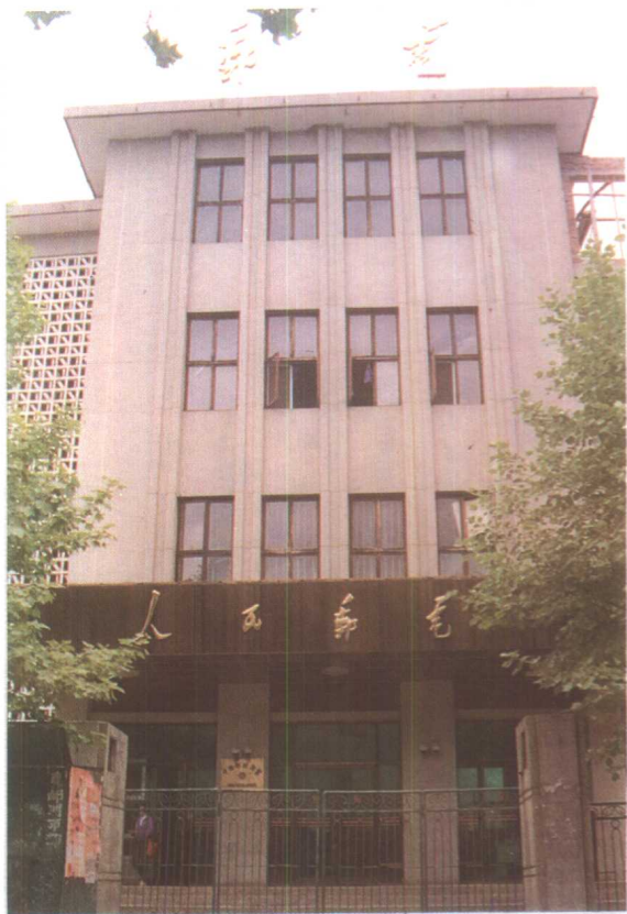
风冈县邮电局大楼
