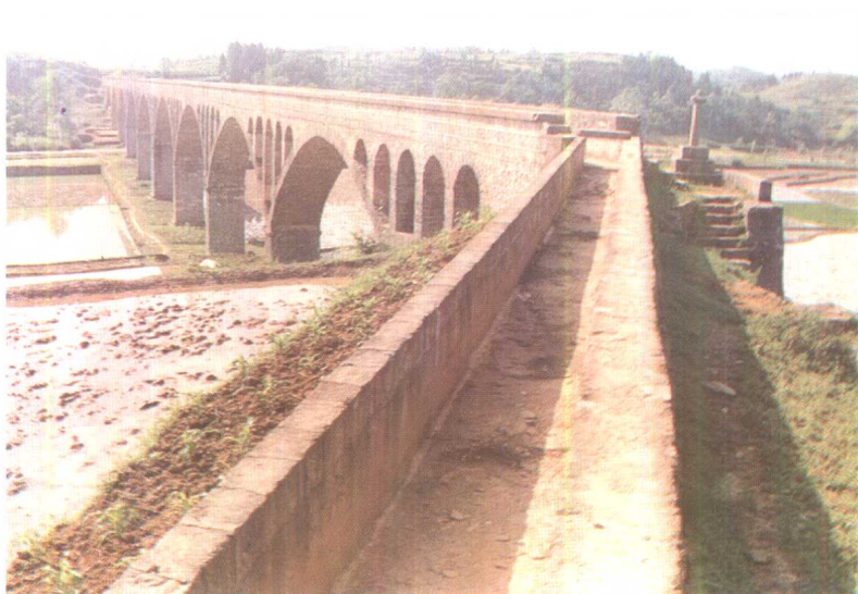
邳川朝阳百孔渡槽
