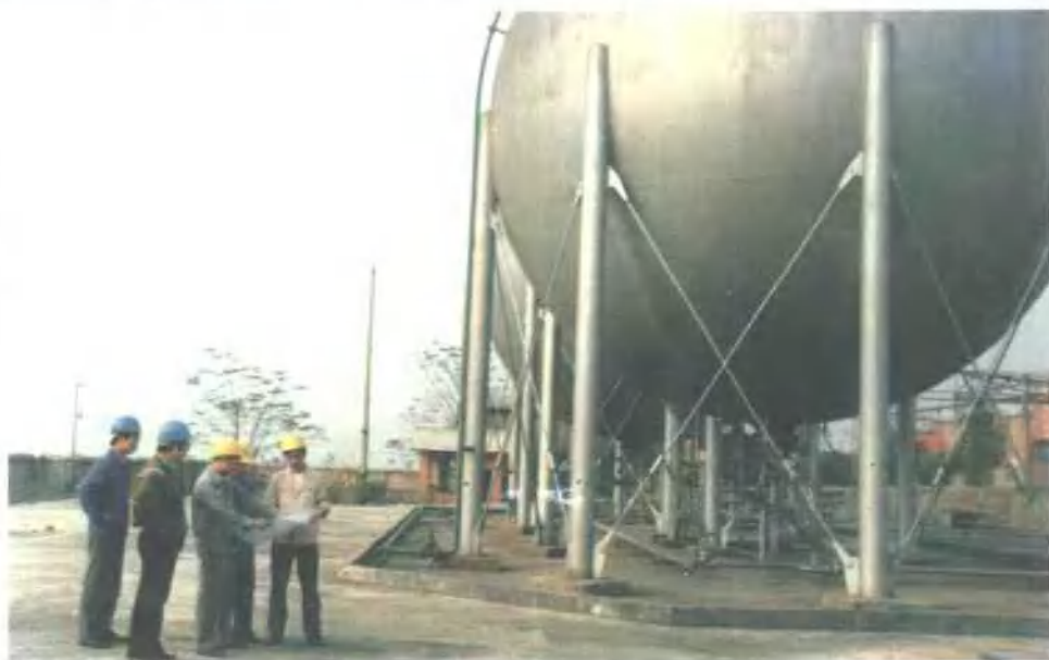
自治区锅炉压力容器检验所的领导和工程技术人员在现场作检验准备工作。
