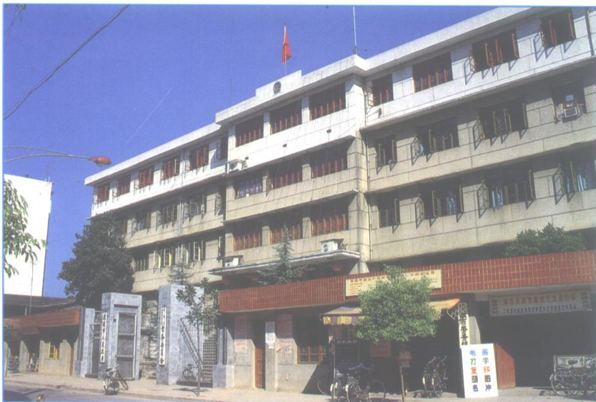
县政府办公大楼
