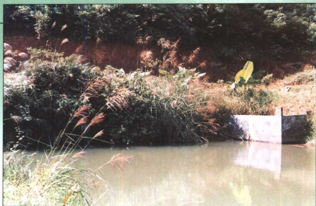
▲一级蓄水塘。容积约100米 3 。位于养殖场最高处，下可自流注水入池，实行自动排灌。塘底有多眼山泉，池水常年不干。
