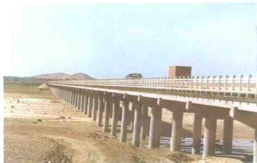
205国道滦河大桥全长1252.91米
