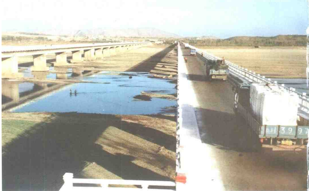
205国道滦河大桥 全长988.89米
