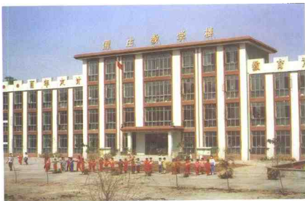
雷庄小学太阳能教学楼
