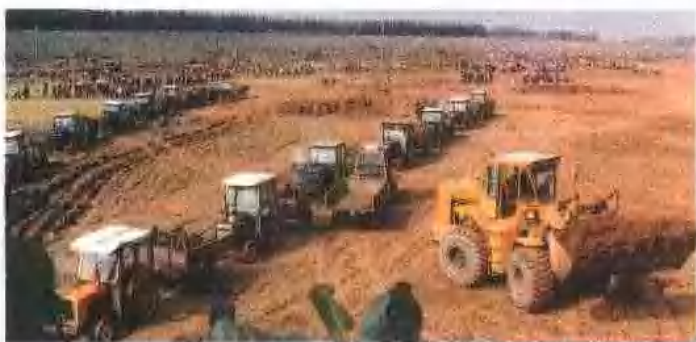
机械施工筑堤防
