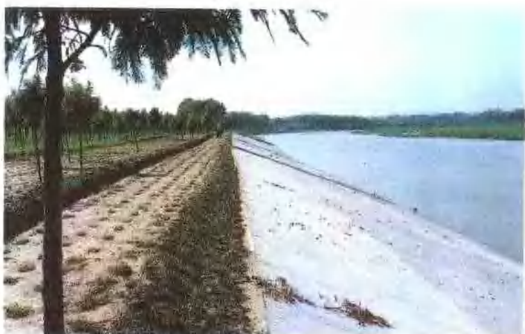
汉江护坡工程
