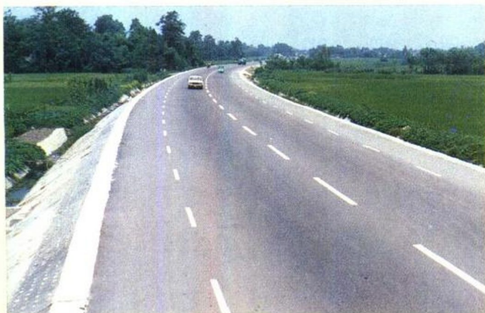
▲大件公路南段公路弯道
