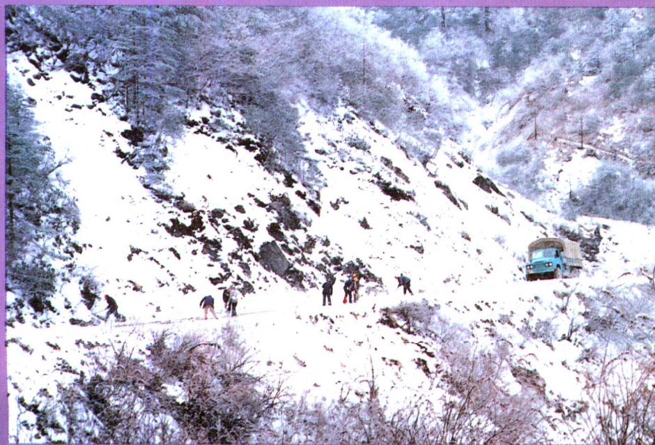
天全养路段二郎山 道班工人,在大雪封山 的恶劣条件下,坚持修 整路面,铺撒防滑沙,保 障道路畅通和行车安 全。
