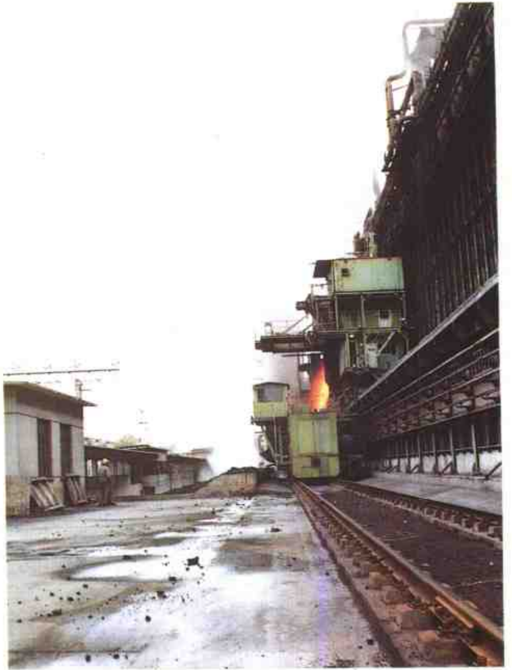
马钢焦化厂五号焦炉
