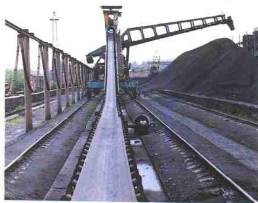
马钢第一烧结厂料场
