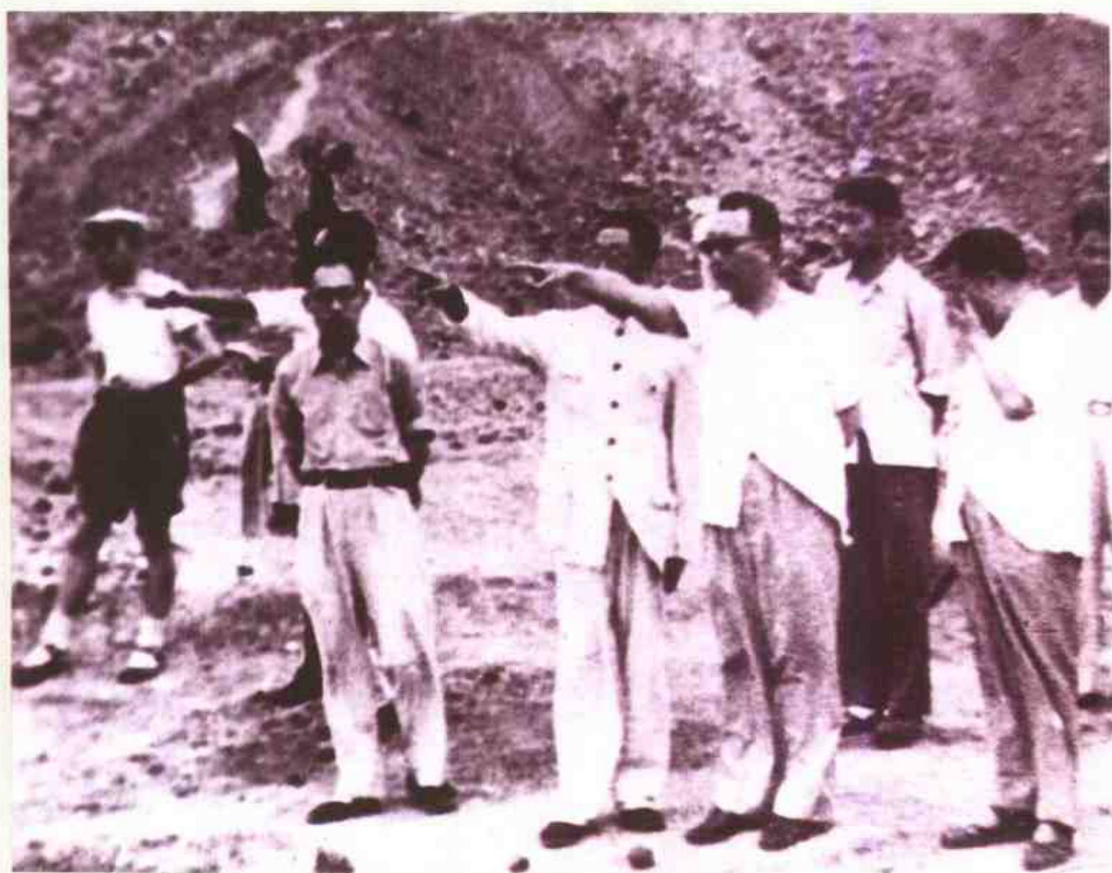
1959年6月16日，聂荣臻副总理在马钢南山铁矿视察。
