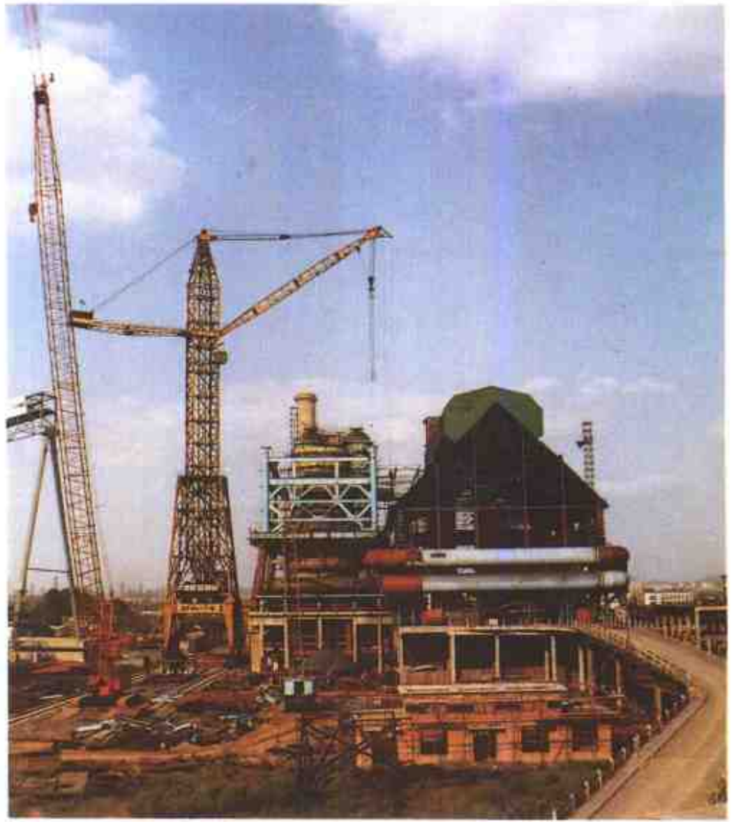
马钢2500立方米大高炉建设工地
