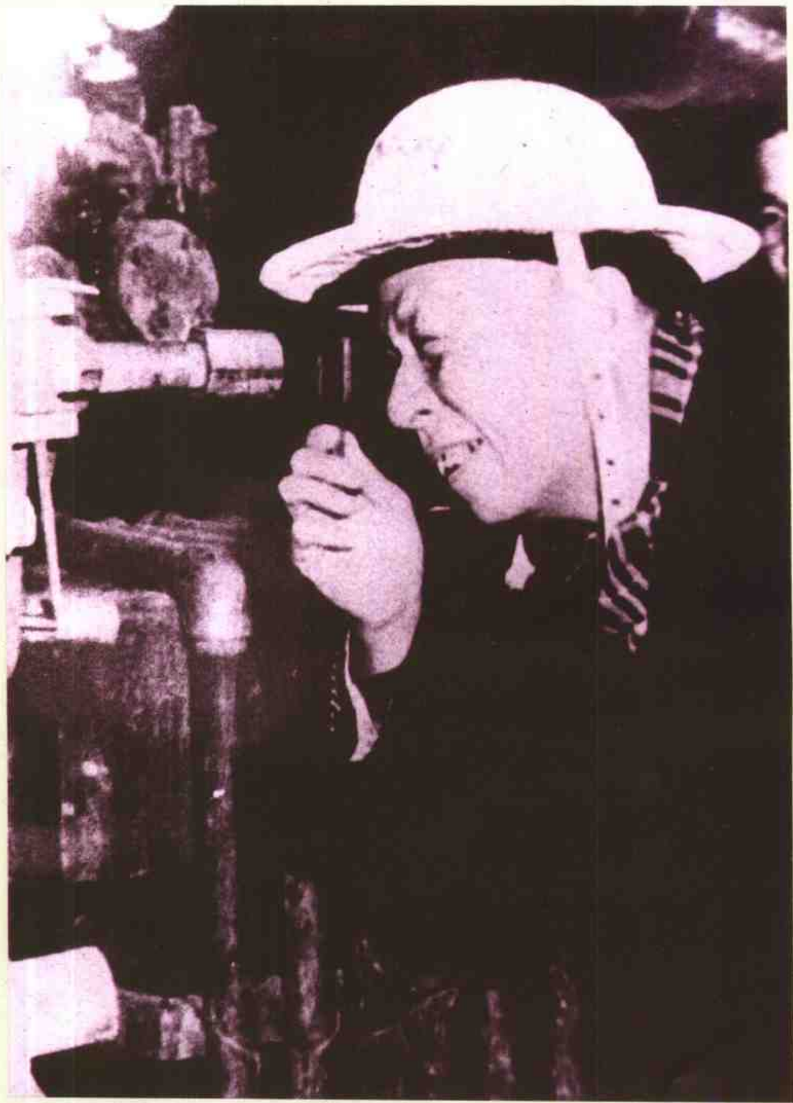
1958年10月22日，刘少奇委员长在马钢十号高炉炉台用探火镜观看炉内燃烧情况。
