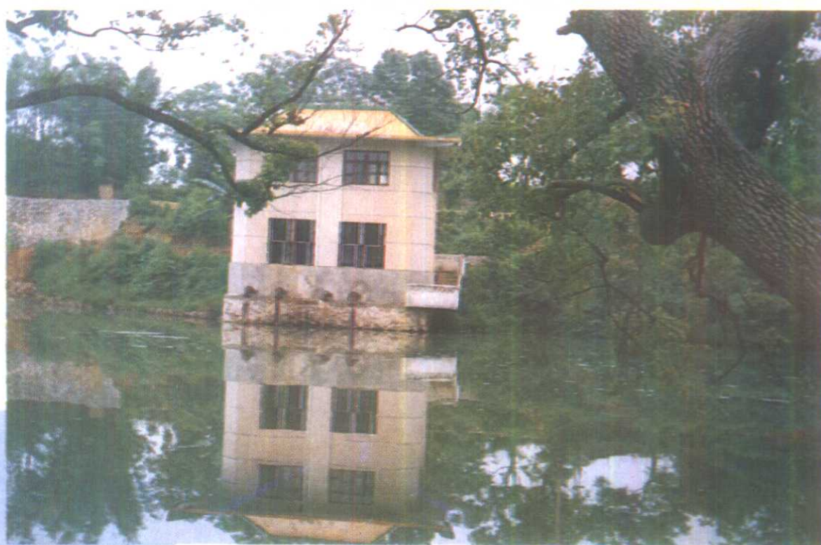
▶ 斑山尾电站大坝左岸电灌站
