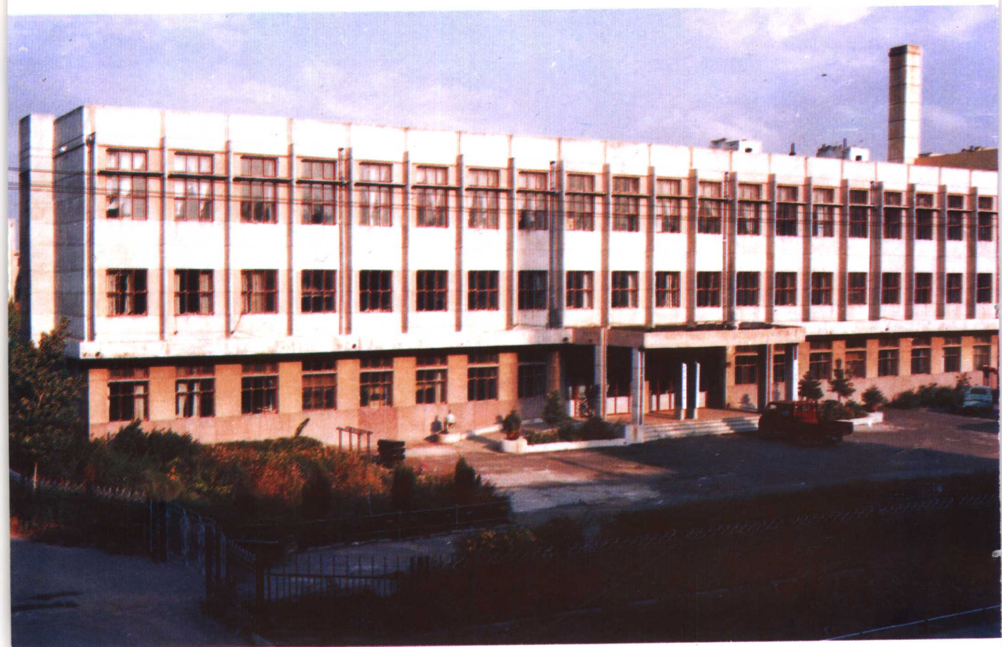
黑龙江省计量检定测试所大楼
