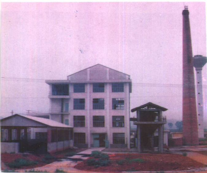
兴义卷烟厂锅炉车间
