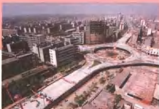
位于市中心的长虹大道立交桥
