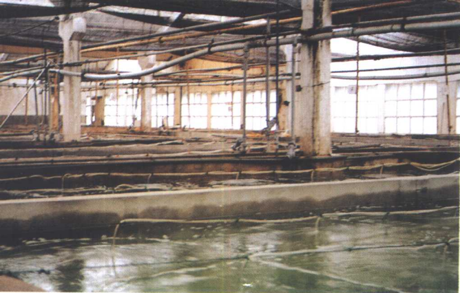
鳗苗中转暂养池
