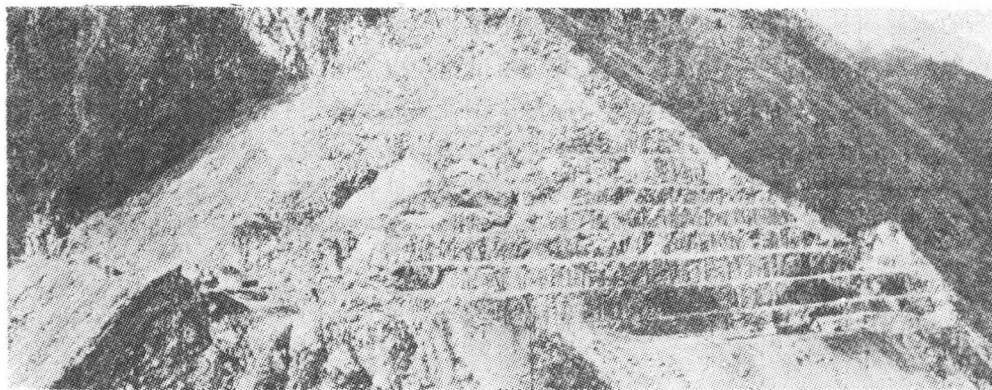
图1—6 在哥伦比亚Chivor坝左肩上开挖的溢洪道。请注意图中的汽车和铲土机，它们可做为比例尺。施工中，因在中左部发现光滑的不连续面而改变了设计。台阶宽为5米，间距为10米。（据Ingetec Ltda.,Bogota）
