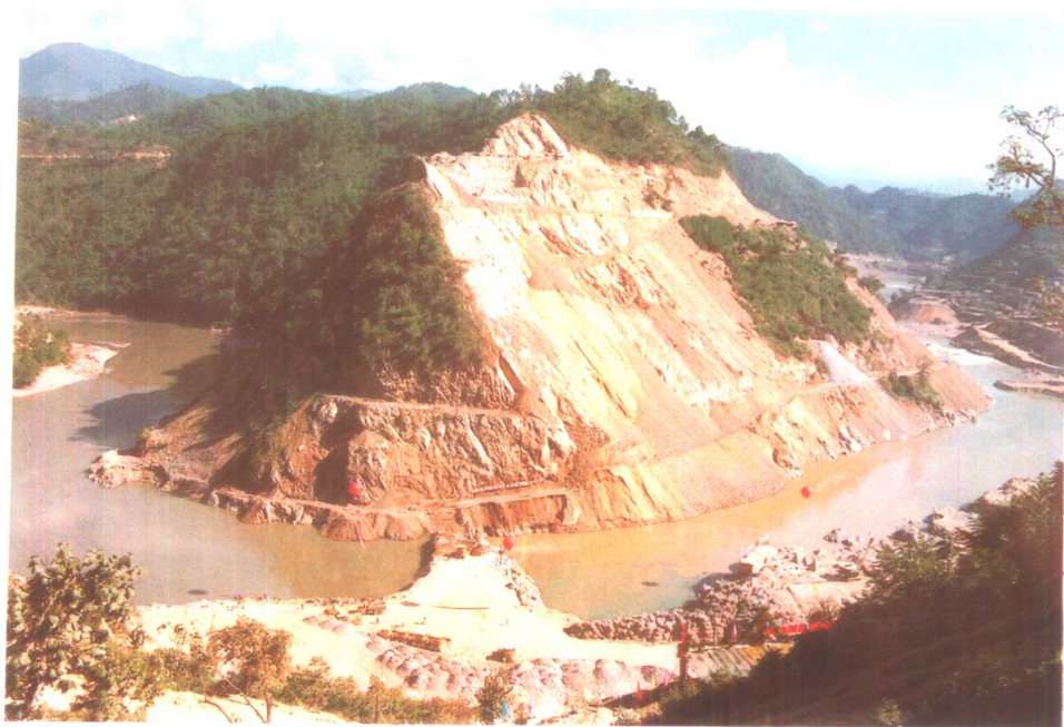
漫湾电站大坝坝址
