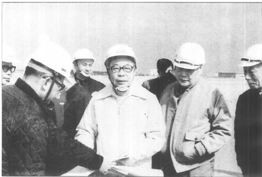
蒋经国察看桃园机场施工跑道
