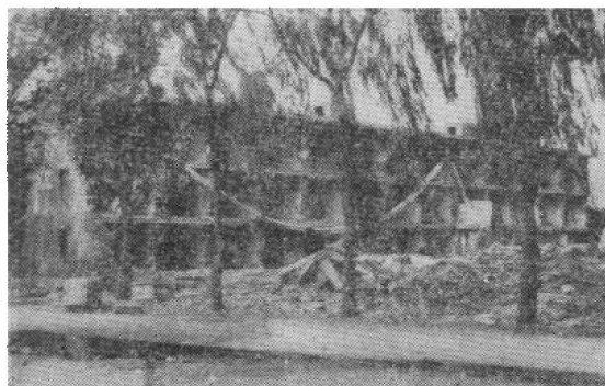
照片1.4 唐山铁道学院住宅，外纵墙全部倒塌
