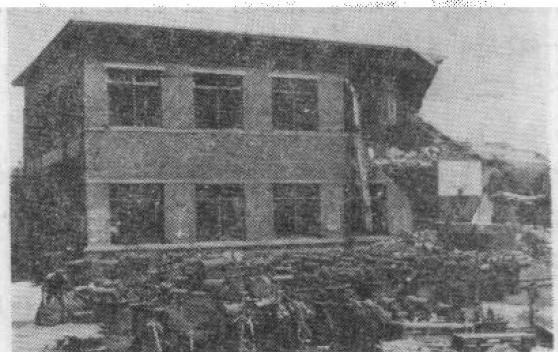
照片1.5 海城变压器厂办公楼东半部上层倒塌
