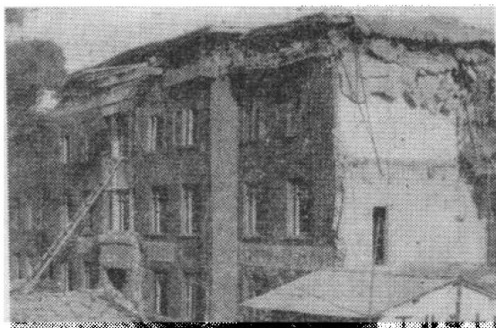
照片1.2 五层的河北煤矿设计院办公楼（西段）上部二层倒平，塌落在第三层顶板上
