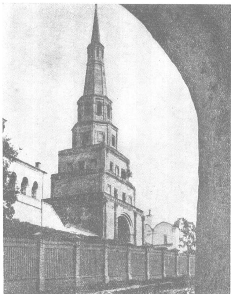
(7) 塔山——變型建築
